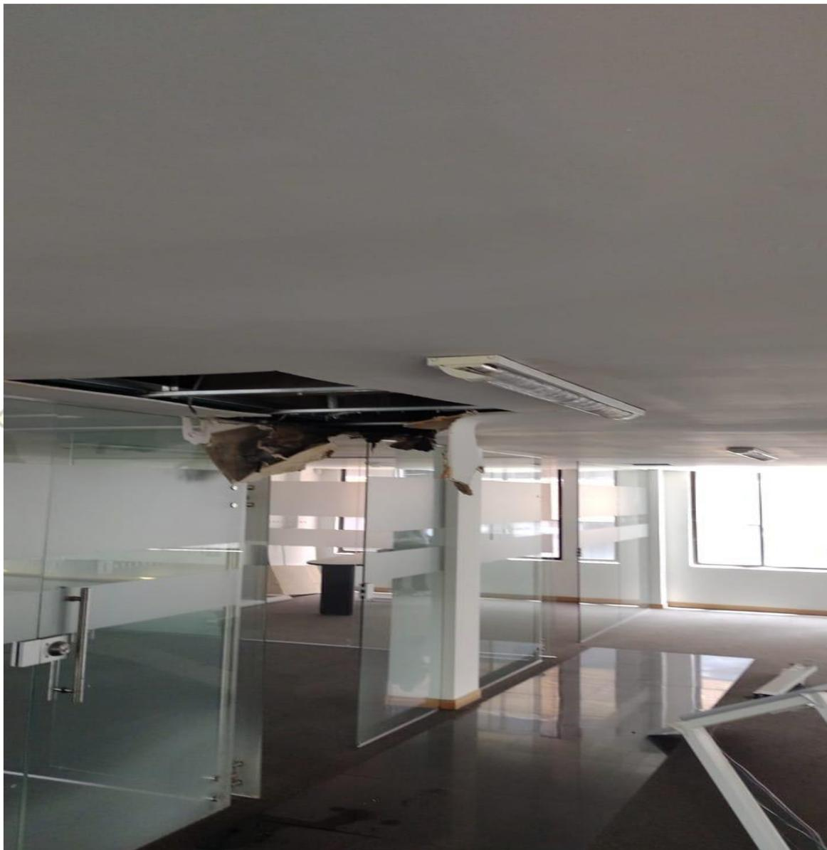
5. ACA HAY OTRA IMAGEN DE OTRA FILTRACION EN EL CUARTO PISO, CAUSADA TAMBIEN POR LAS GRIETAS DEL LEVANTAMIENTO DEL MANTO ASFALTICO EN LA TERRAZA DEL ADIFICIO, A MEDIANO PLAZO SE DEBE IMPERMEABILIZAR LA TERRAZA.
